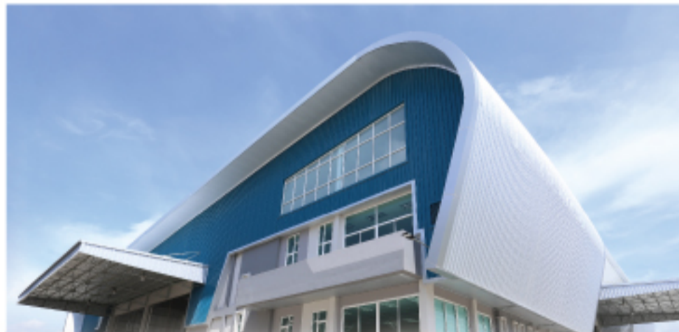
Low Voltage Switchboard Manufacturing Plant โรงงานผลิตตู้สวิตช์บอร์ดและระบบควบคุมการจ่ายไฟฟ้า
