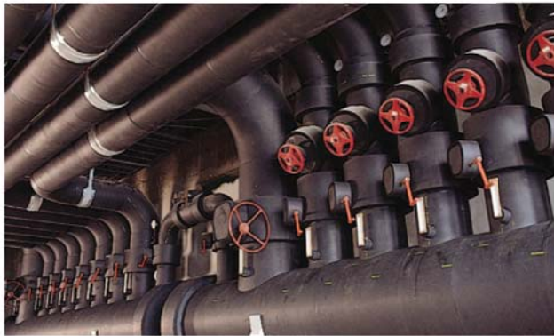
แอร์โรฟлексมีคุณสมบัติดับไฟได้เอง มีความยืดหยุ่นสูงและง่ายต่อการติดตั้ง ฉนวนแอร์โรฟлексจึงเป็นฉนวนที่เหมาะสมกับอาคารต่างๆ เนื่องจากความปลอดภัยและช่วยป้องกันปัญหาหยดน้ำของท่อน้ำเย็น
