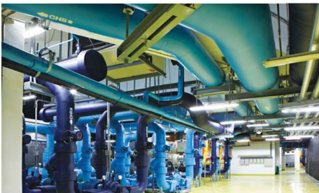
ค่าสัมประสิทธิ์การนำความร้อนต่ำคงที่ มีการดูดซึมน้ำและการแทรกซึมของไอน้ำที่ต่ำ ทำให้ฉนวนแอร์โรฟлексใช้ในระบบท่อน้ำเย็นกันอย่างแพร่หลาย
